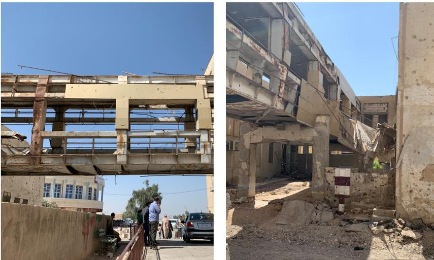
Abbildung 3 – Der Eingang zur Notaufnahme des Nationalen Krankenhauses von Rakka und der Gehweg zum derzeit nicht funktionsfähigen Teil des Krankenhauses. Sie sind durch Explosionen und Beschuss mit Kleinwaffen beschädigt. Die Fenster sind herausgesprengt und es gibt erhebliche strukturelle Schäden. © Mit freundlicher Genehmigung eines internationalen Akteurs der humanitären Minenaktion in Syrien.
